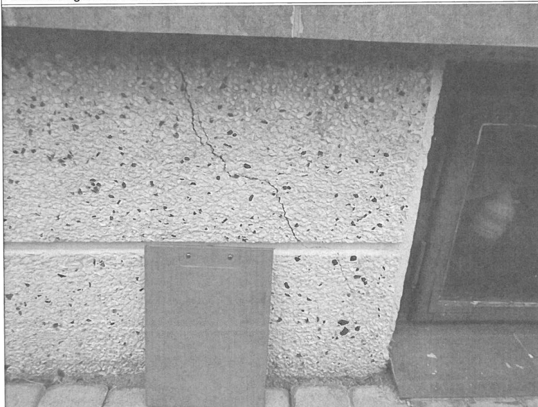
Spękania w fundamencie
