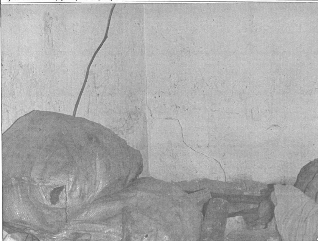
Pęknięcia w ścianie kotłowni (budynek nr 143)
