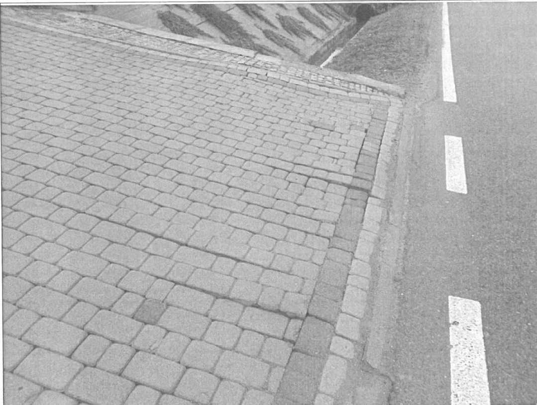
Wybrzuszenia i pęknięcia w podjeździe do posesji nr 171
