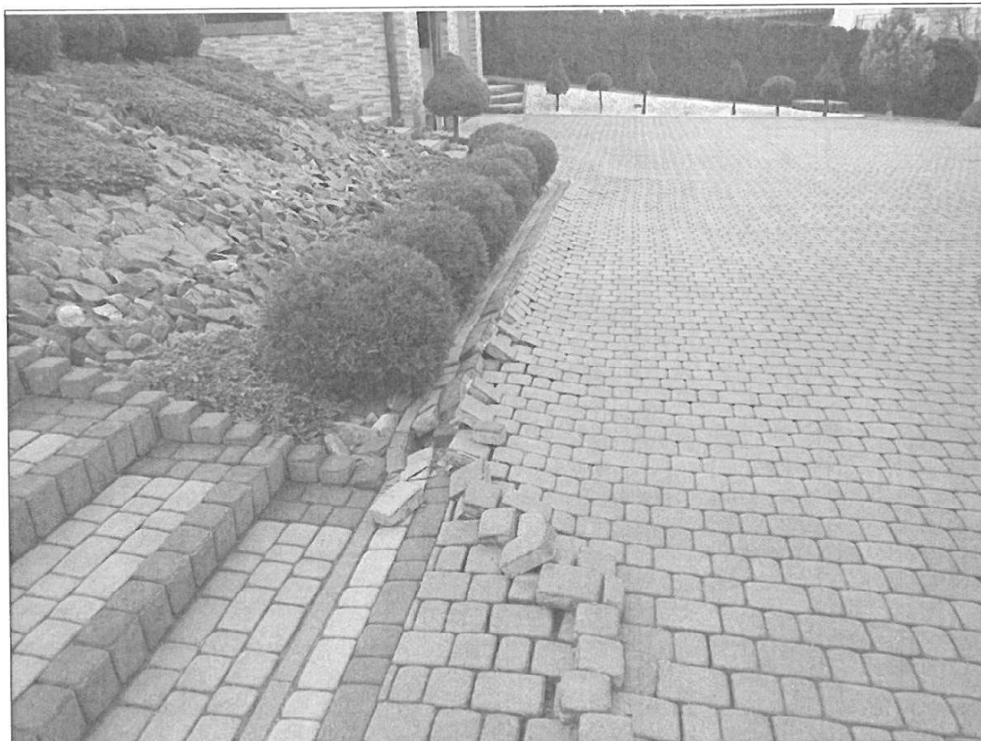
Uszkodzona kostka brukowa powyżej budynku nr 171
