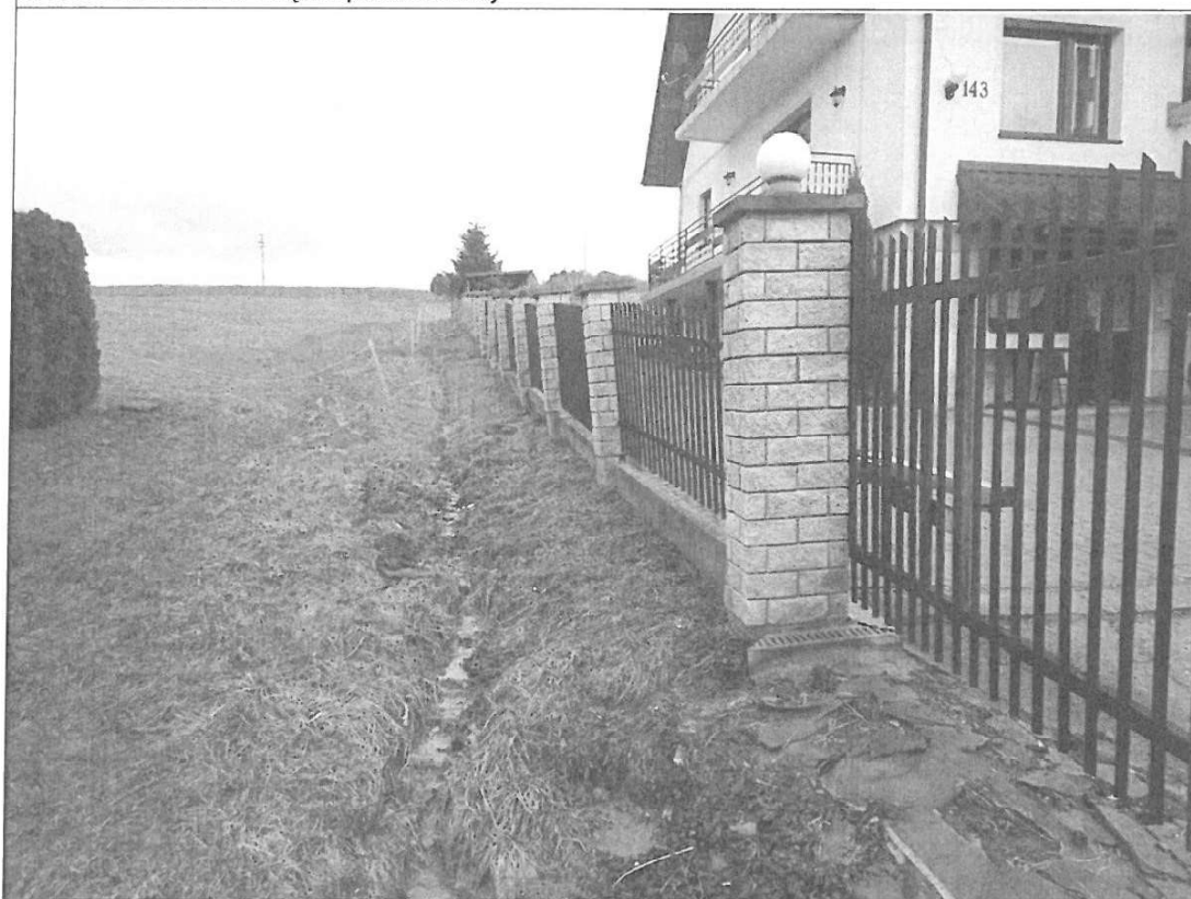
Widoczne odchylenie od pionu ogrodzenia
